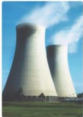
Las centrales nucleares, como esta central francesa, están siempre cerca de agua para poder refrigerarse.
